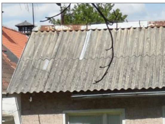
Fot.1 Płyty azbestowo-cementowe faliste
