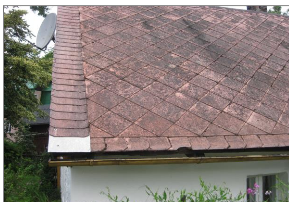
Fot. 2 Płyty azbestowo-cementowe płaskie
