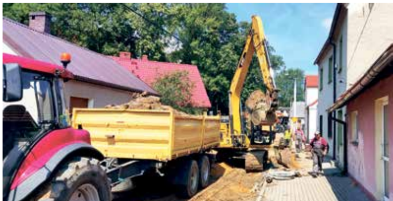
Roboty na ul. Mickiewicza.
