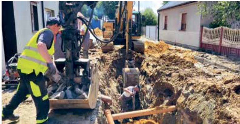
Prace ruszyły na początku sierpnia.
