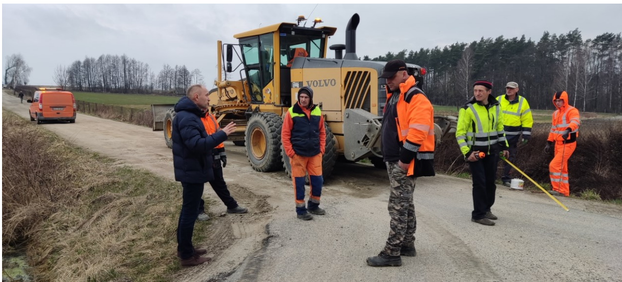
Przebudowa drogi w Przedborowie
