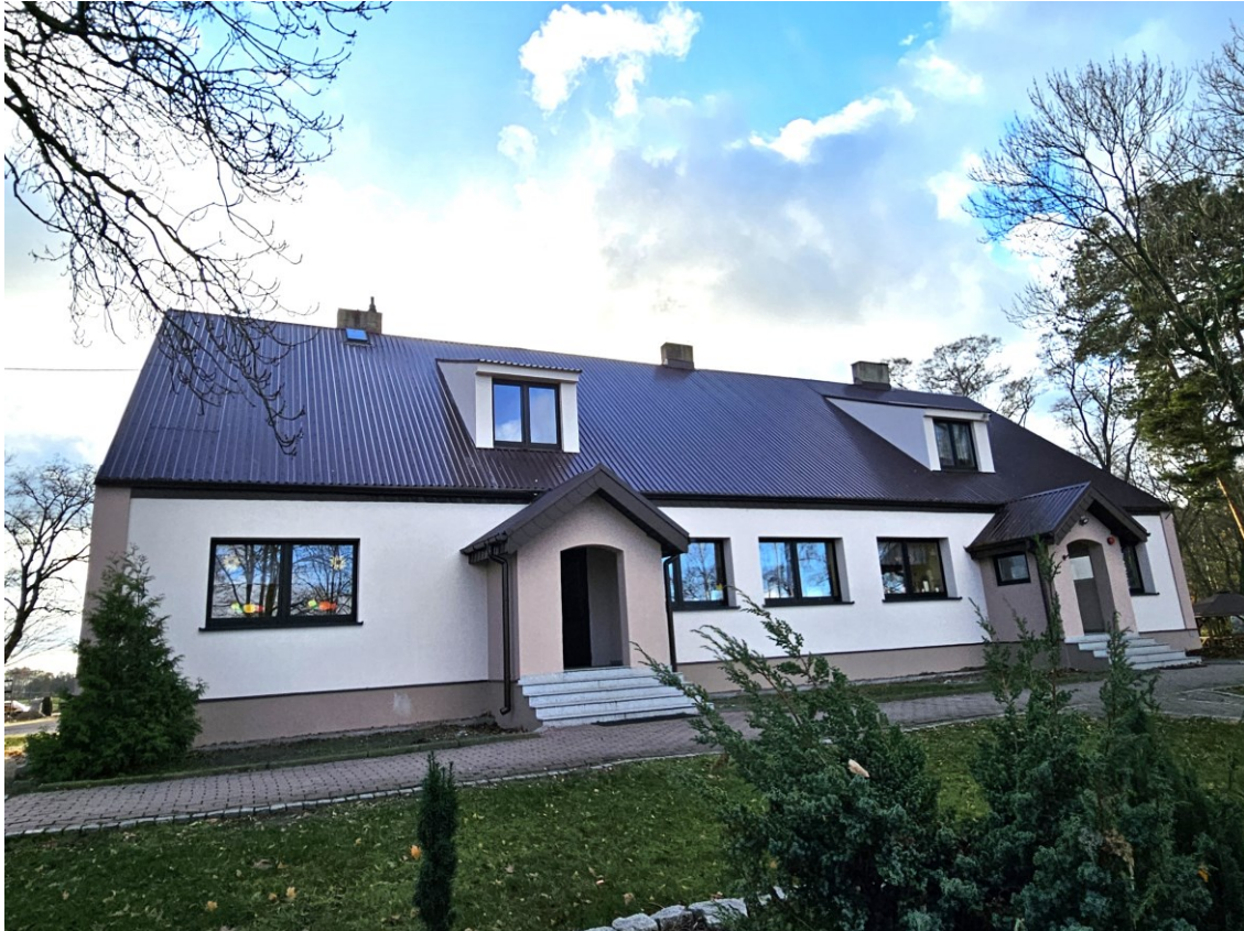
Budynek Szkoły Podstawowej w Kaliszkowicach Ołobockich po termomodernizacji
