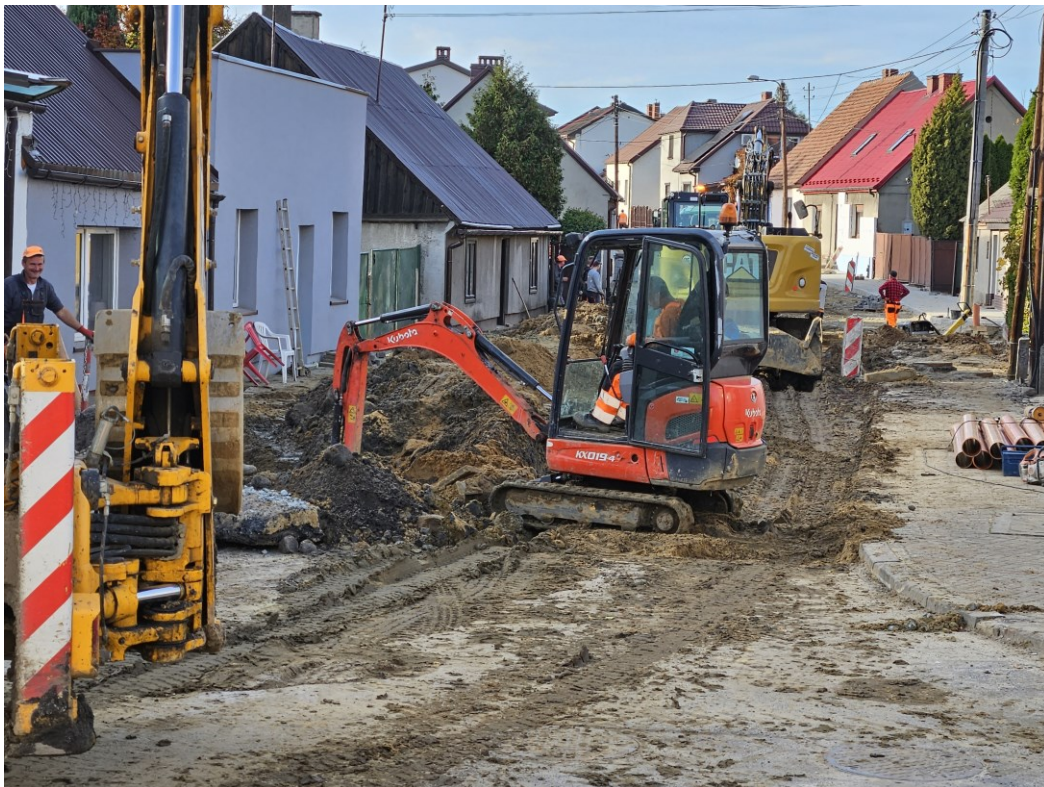
Wymiana instalacji komunalnych na ul. Odolanowskiej w Mikstacie
