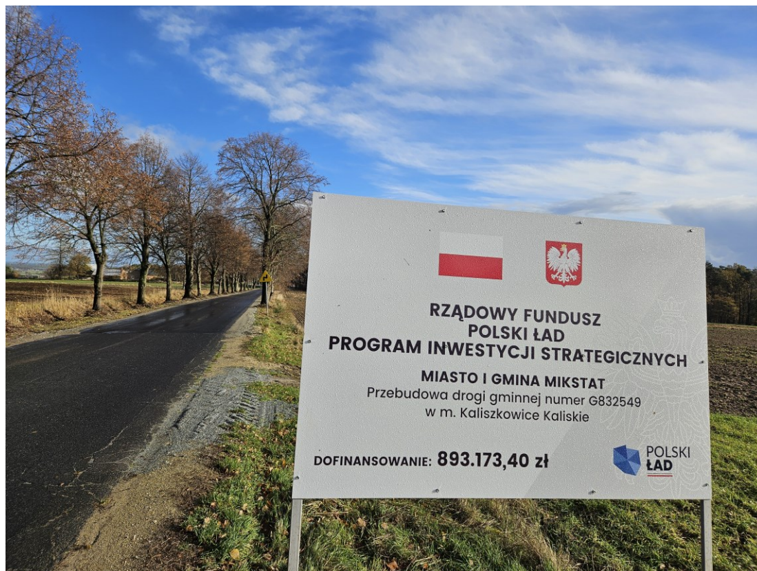
Modernizacja drogi gminnej wsparta dotacją z „Polskiego Ładu”
