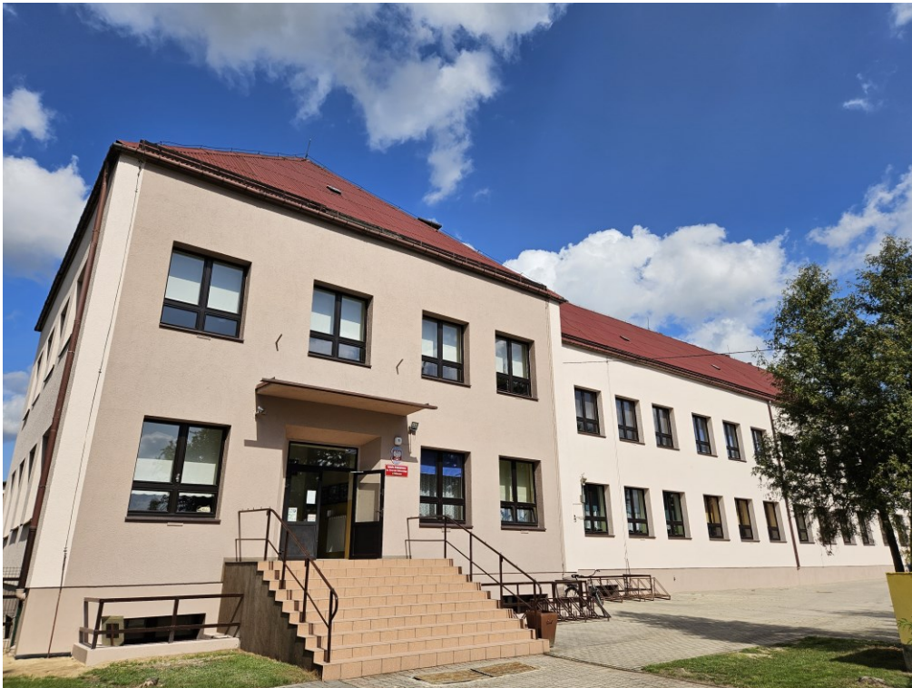
Budynek szkoły w Mikstacie po termomodernizacji
