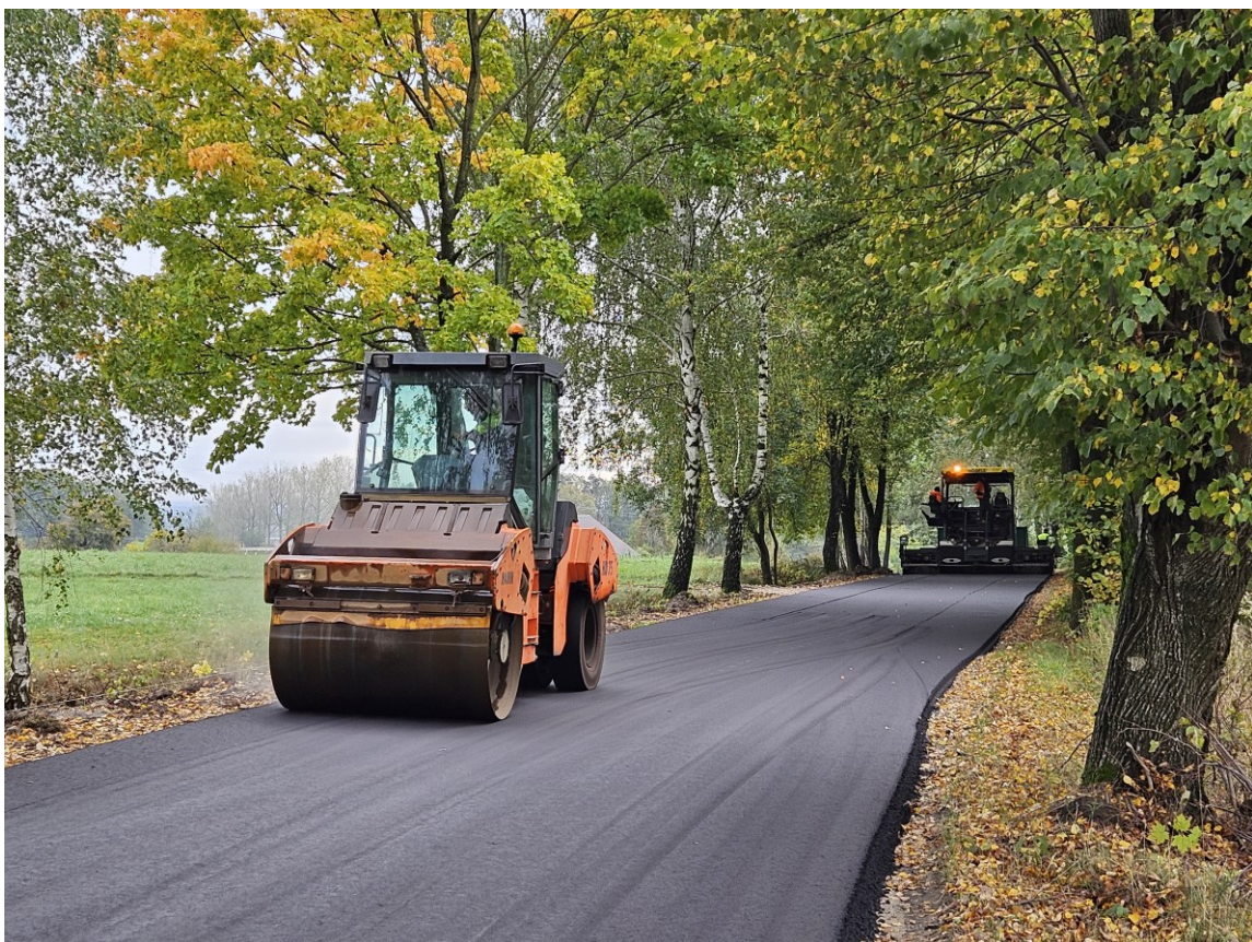
Modernizacja drogi w Kaliszkowicach Kaliskich
