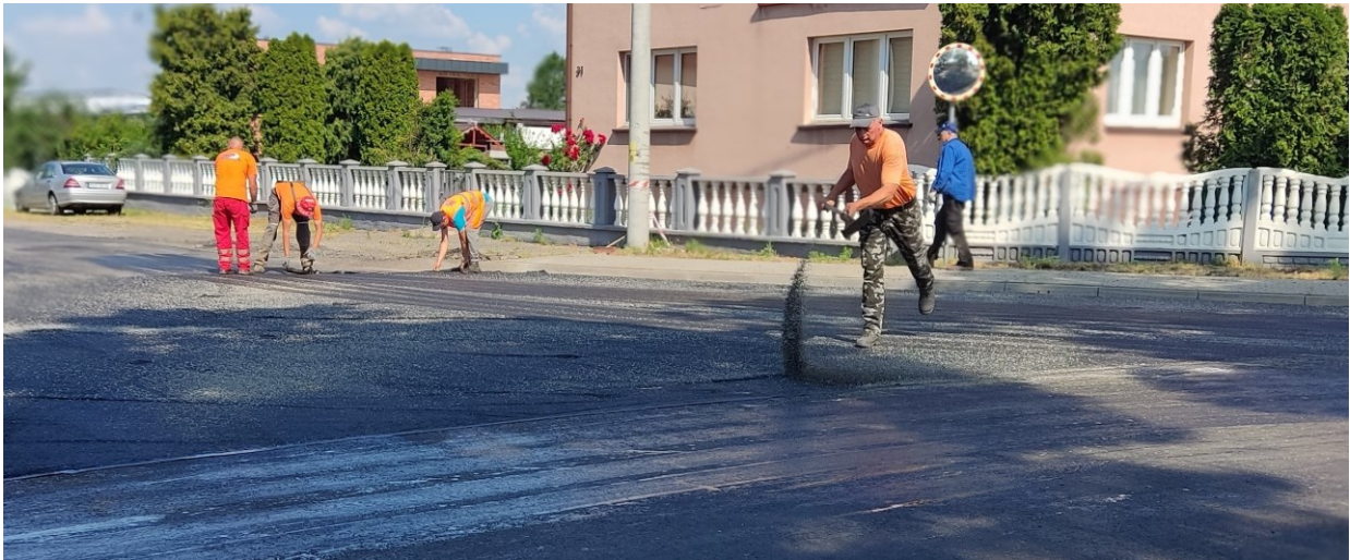
Modernizacja nawierzchni na skrzyżowaniu w Kaliszkowicach Ołobockich
