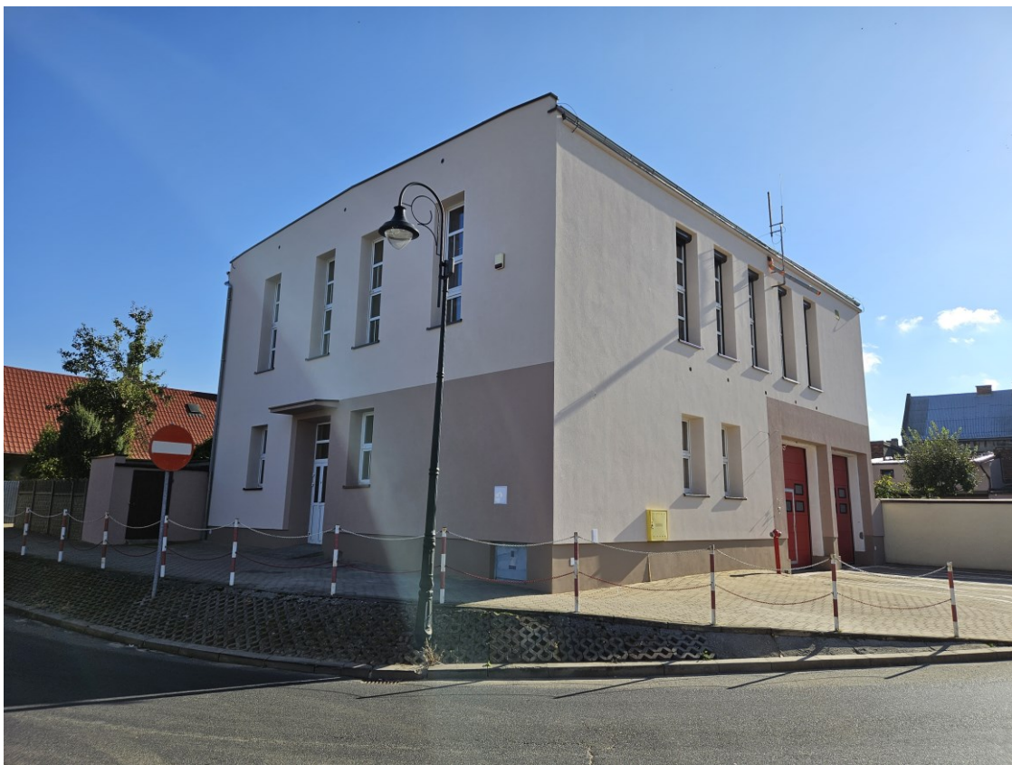
Budynek MGOK-u i remiza OSP Mikstat po termomodernizacji
