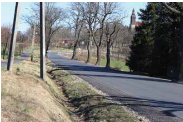
Droga w Kotłowie.
